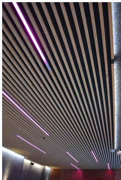
Foto 12. Loftet i Vejen Svømmehal med farvet lys og ekstra akustisk beklædning.
