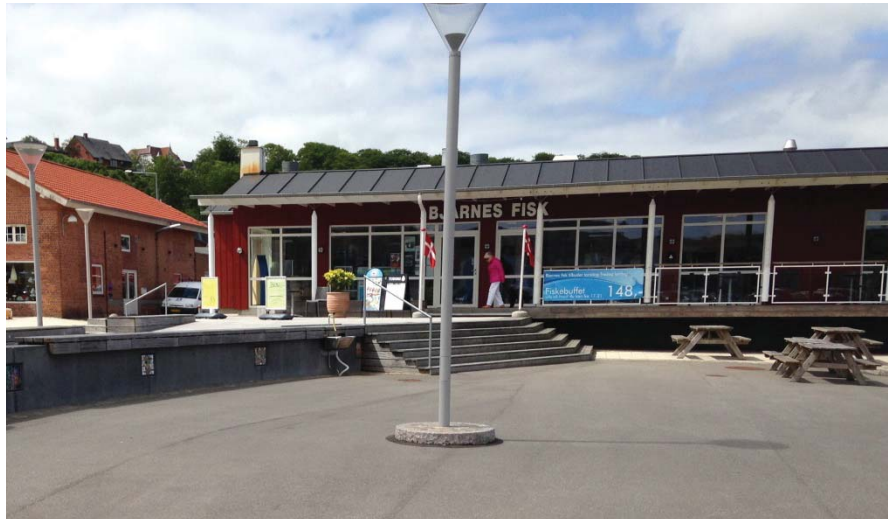
Figur 4.12: Hævet bygning på havnen i Lemvig, hvor gulvniveau ligger på niveau med højvandsmuren
