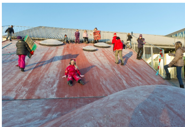
Trekløverhallen i Stepping efter ombygningen. Foto: Rune Johansen.
